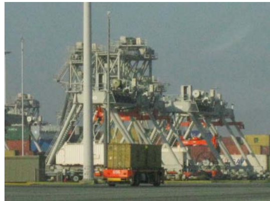
(自動スタッキングクレーンとAGV)
