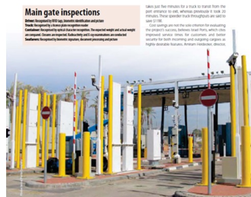
保安ゲートは、自動的にトラック、ドライバー及びコンテナ番号を認証する。
